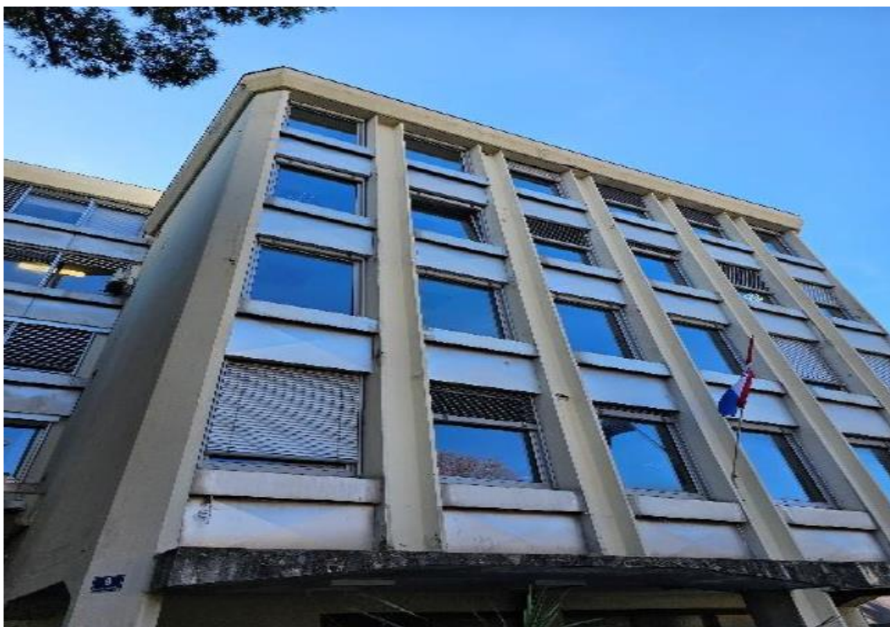
Prilog br. 6. – Slike postojećeg stanja zgrade predmeta nabave na lokaciji Naručitelja
